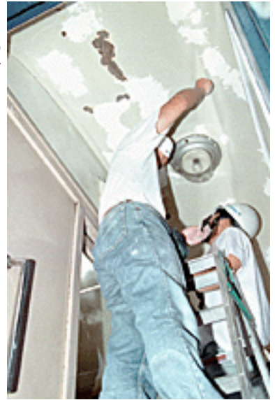
スハフのデッキ天井の痛んだ塗装を剥がす
