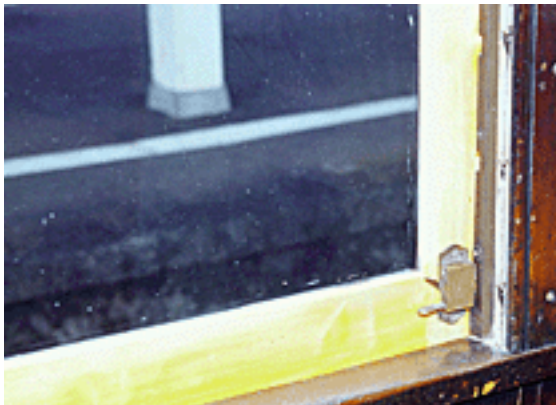
雨樋と窓枠を新品に交換しました。 塗装色の違いにご注目
