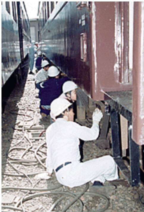
意に反し本線寄り側線に留置されたため、 外回りの補修は東側に限定
