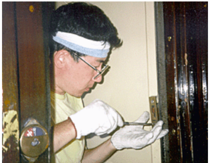
傷みを見つけたら、自主的に修理していきます
