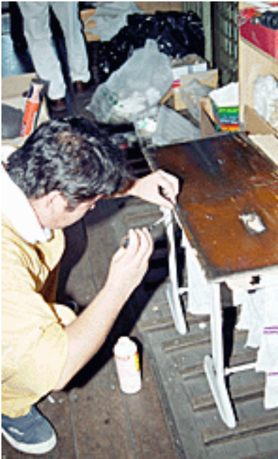
漏水で痛んだオハニの内装を補修する湯本さん
