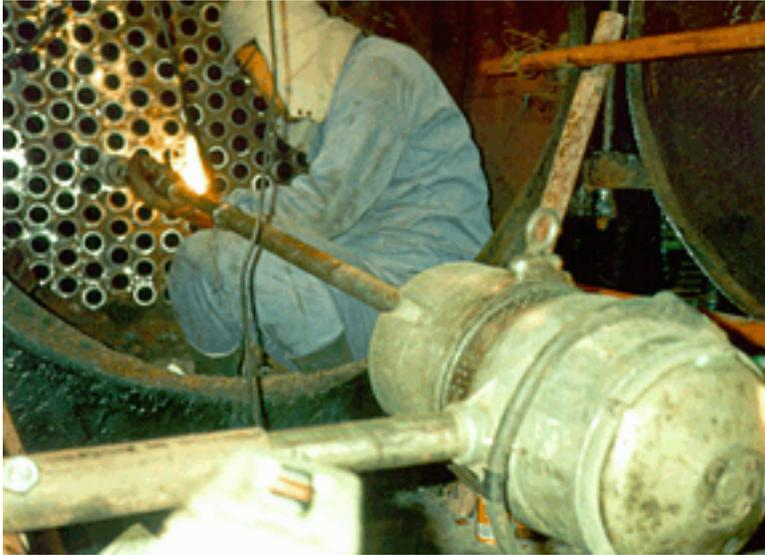
電動エキスパンダによる煙管工事(B6)
