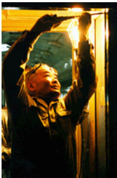
貫通扉部分を補修する後藤さん
