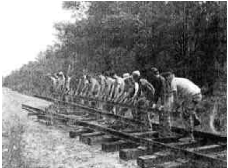
アメリカ・シーショアトロリーミュージアムの線路工事(いずれもボランティアによる)
