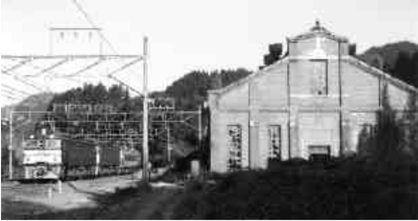
旧丸山信号所付近の変電所建物
