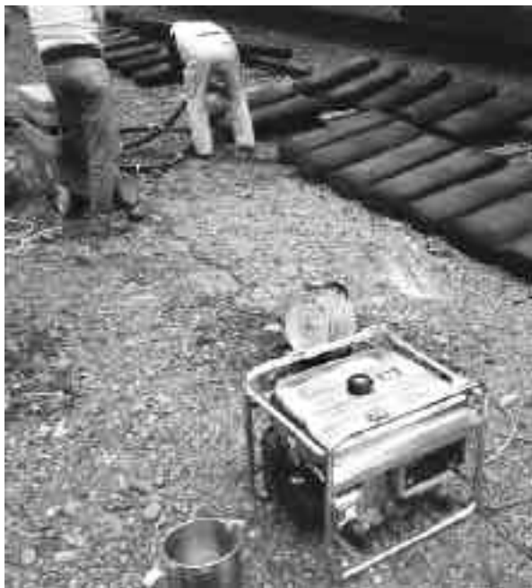
高圧洗浄機とともに、今回初めてレンタルした発電機 洗浄機のほかにも、電動工具の電源として大活躍した
