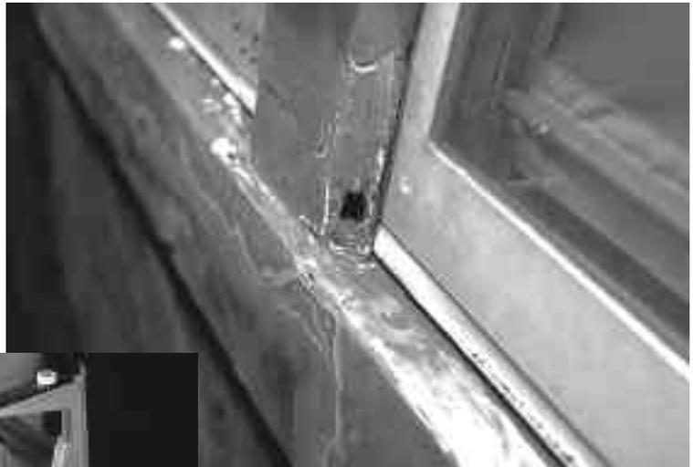
補修前の外部の穴と塗装の縞模様
