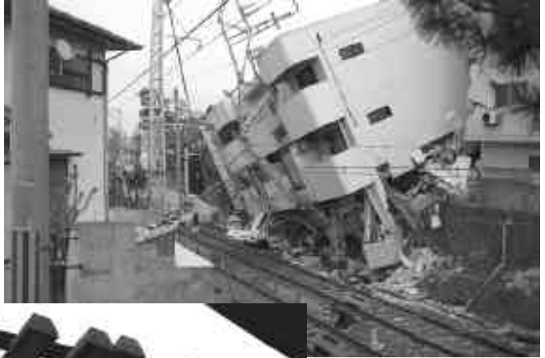
阪急神戸線 夙川駅下り線を塞いだビル
